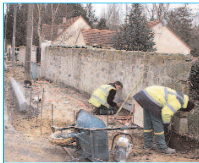
Pendant un mois, des travaux de voirie ont lieu dans la rue de l'Essonne.
